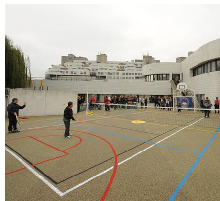
*Réalisations de tapis de sol souples à partir de granulats de caoutchouc issus du broyage des balles.*
